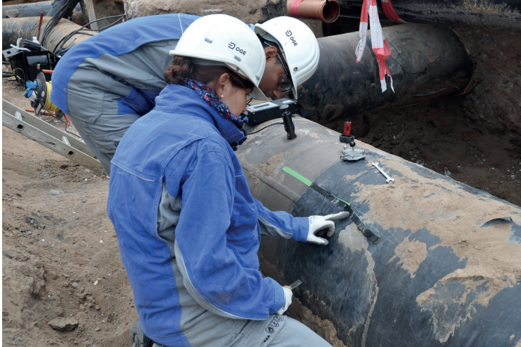
Coating Inspektoren im Einsatz
